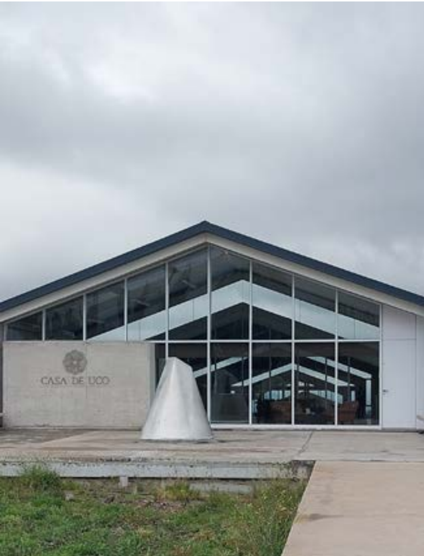
Bodega Casa de Uco
